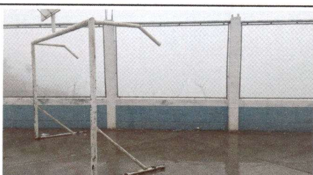
Foto 5: Reparación de tubo HG y malla galvanizada, por malla acerada
