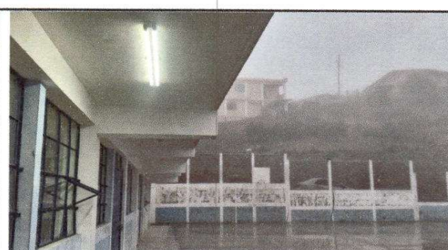
Foto 6: Sustitución de lámparas de 2x40
