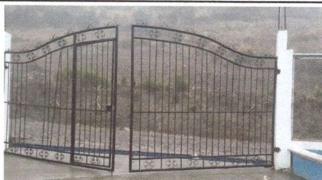
Foto 3: Mantenimiento a porton de metal
