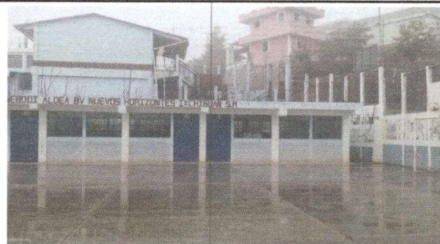
Foto 2: Pintura en muros exteriores e interiores
