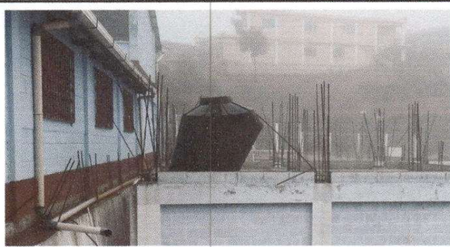
Foto 8: Sustitucion de deposito de agua 1700L por uno de 2500L
