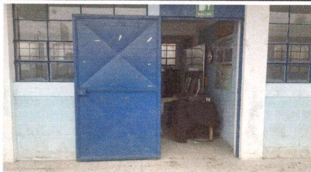
Foto 1: Sustitución de Chapas
