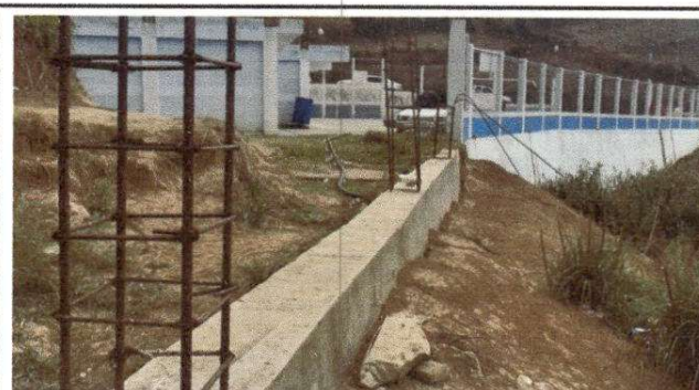
Foto 4: Reparación de muro perimetral con tubo HG y malla galvanizada, soleras intermedias y columnas
